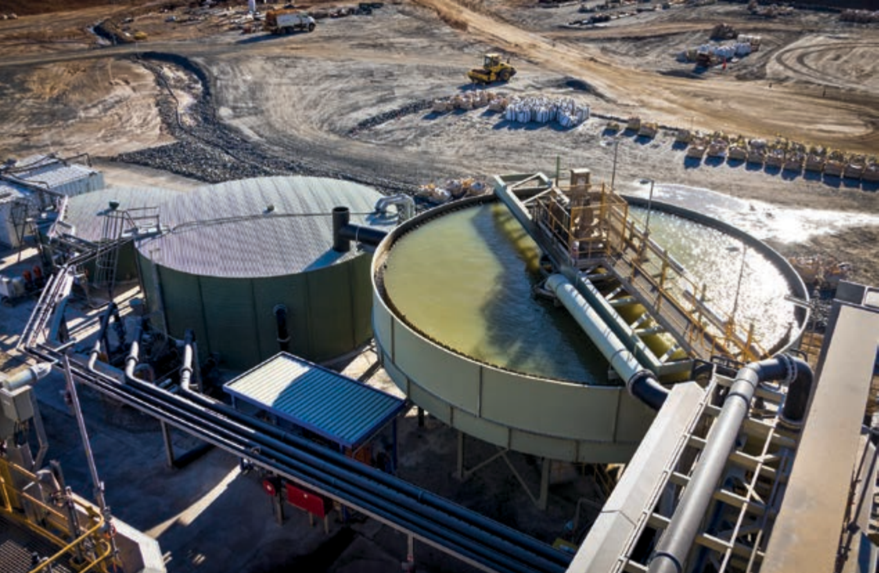
Εργοστάσιο επεξεργασίας Λιθίου στην Δυτική Αυστραλία.
