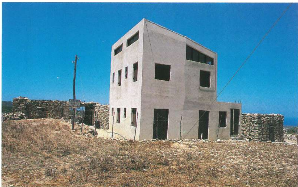
Ανάμεσα στα ταπεινά λιθόχτιστα σπιτάκια υψώνει αλαζονικά τον όγκο του αυτό το τριόροφο κτίσμα στα Βασιανά, σε απόλυτη αντίθεση με το περιβάλλον.
