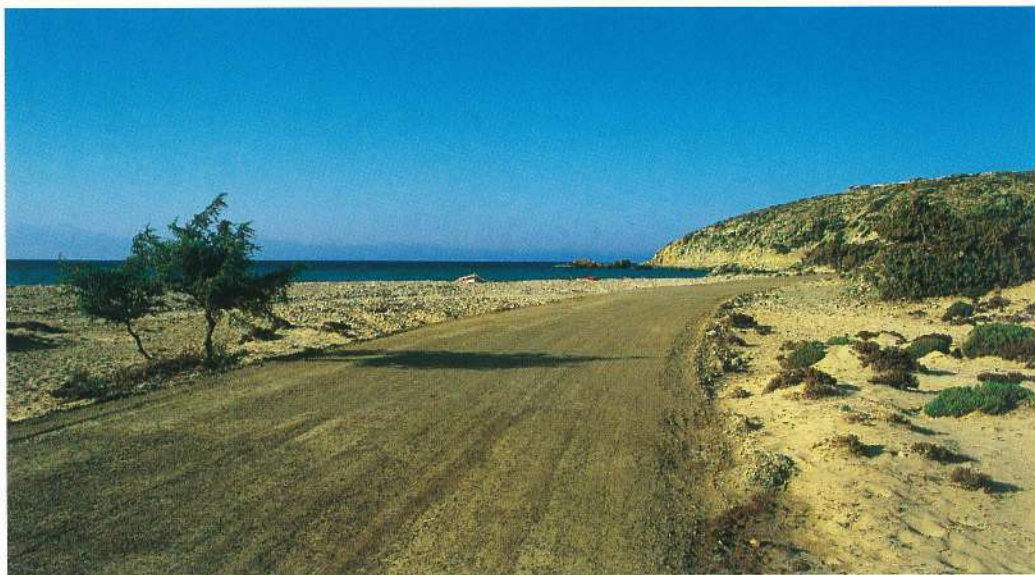
Ο δρόμος που οδηγεί στο Σαρακήνικο. Αυτή τη στιγμή γίνονται έργα για την ασφαλτόστρωσή του.
