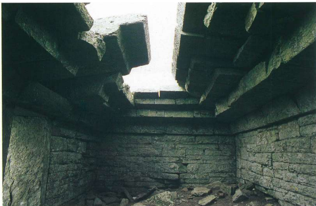
Τα εκπληκτικότερο ίσως δείγμα αρχιτεκτονικής τεχνικής συναντάται στο εσωτερικό του μνημείου και τον τρόπο στήριξης των μεγαλιθικών πλακών της στέγης.
