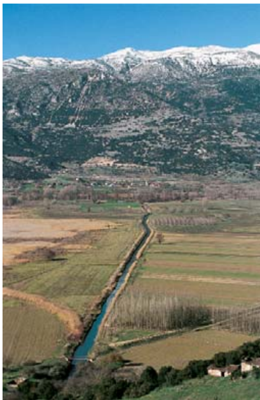
Το μεγάλο αυλάκι που συγκεντρώνει τα νερά της λεκάνης της Στυμφαλίας και τα διοχετεύει στο Αδριάνειο υδραγωγείο. (αριστερά)
