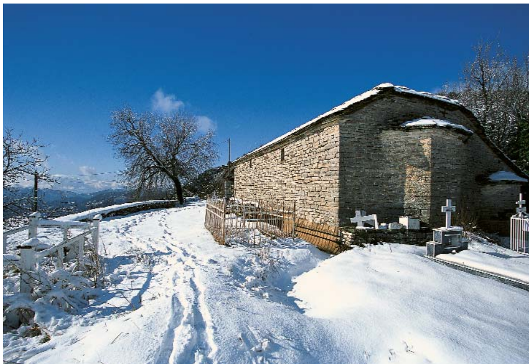
Ναός Κοίμησης της Θεοτόκου, στην είσοδο του Καπέσοβου. Είναι μικρή μονόχωρη ξυλόστεγη αίθουσα με τρίπλευρη αψίδα, χτισμένη με αργολιθοδομή.
