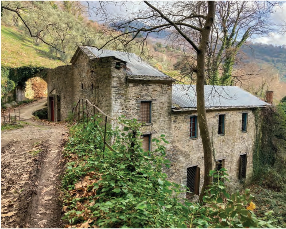
Ο δώροφος μύλος του Μίχου στο έμπα του οικισμού
