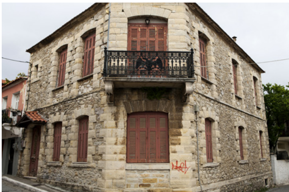
Εξαιρετο πέτρινο σπίτι με ισόδομους γωνιόλιθους στο πλαίσιο των ανοιγμάτων και τις γωνίες. Στο κιγκλίδωμα του μπαλκονιού ο «Δικέφαλος Αετός».
