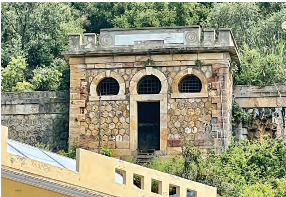
Το περίφημο πέτρινο υδραγωγείο απρόσιτο, αναξιοποίητο, ξεχασμένο
