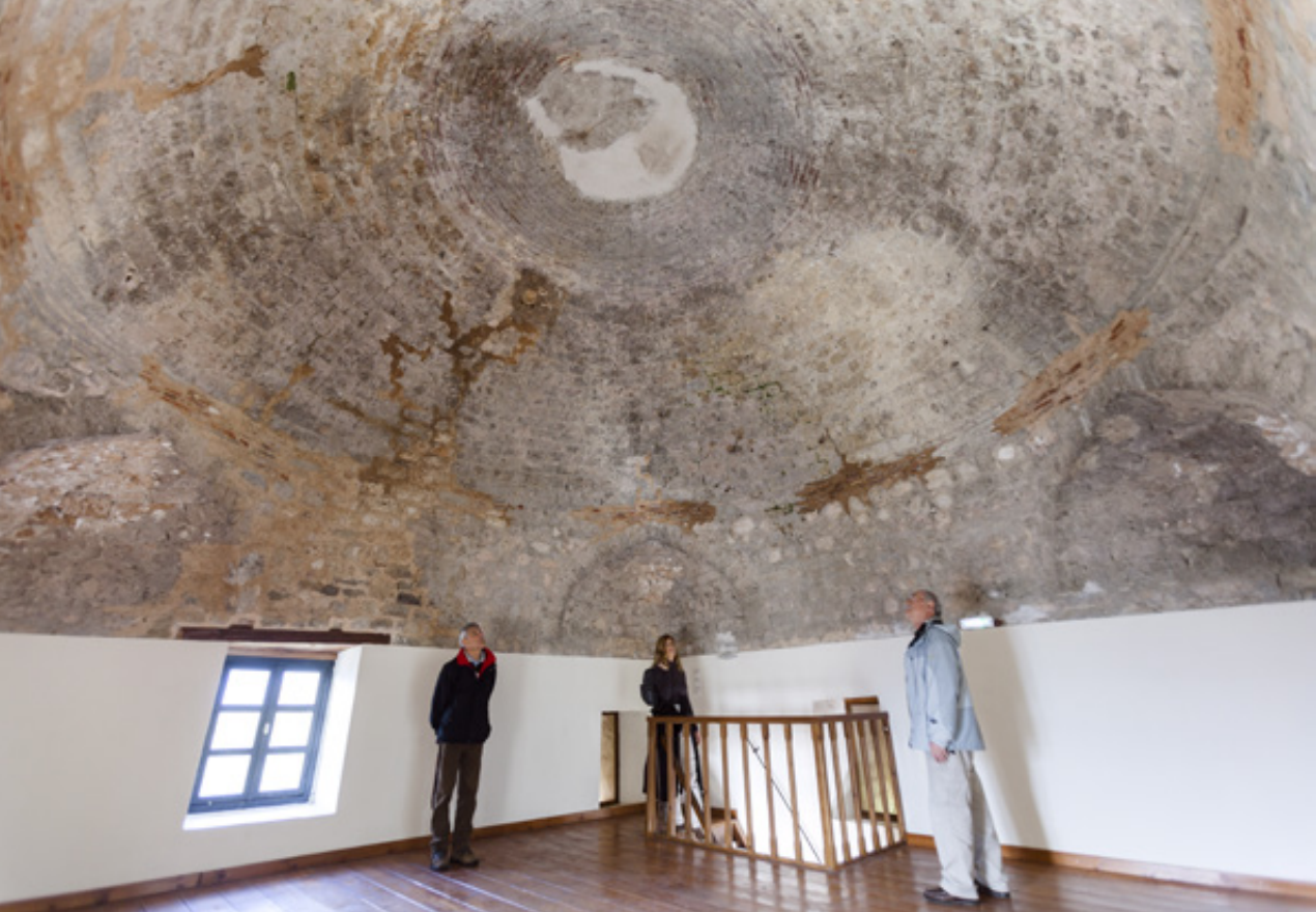
Εσωτερικό του 5ου ορόφου της Κούλιας, με την περίτεχνη θολωτή οροφή.
