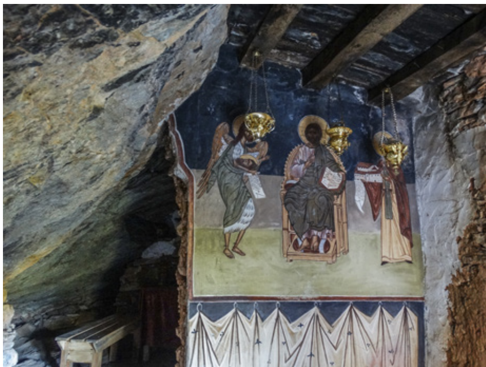
Το ασκηταριό εσωτερικά και εξωτερικά.
