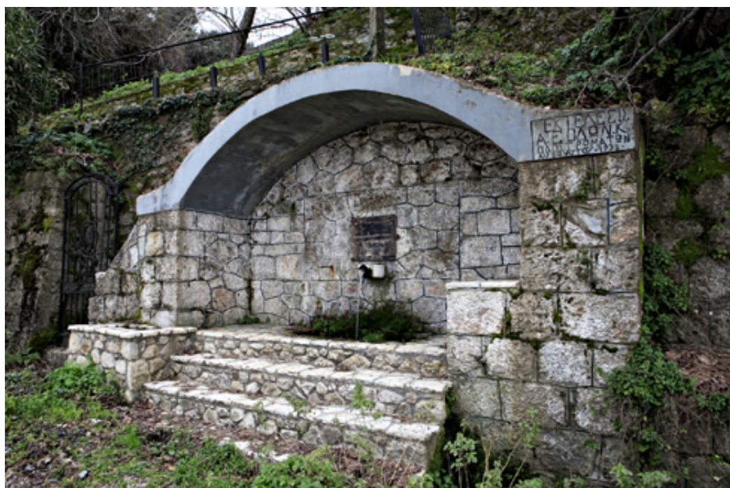
Μια από τις πάμπολλες πετρόχτιστες βρύσες στο Γεωργίτσι. Η συγκεκριμένη έχει κατασκευαστεί από την "Α.Ε. Οδών και Οδοστρωμάτων", τον Αύγουστο του 1938. Στην περιοχή Παρασκέικα, τα άφθονα νερά και η πυκνή βλάστηση δημιουργούν ένα φυσικό περιβάλλον εκπληκτικό.
