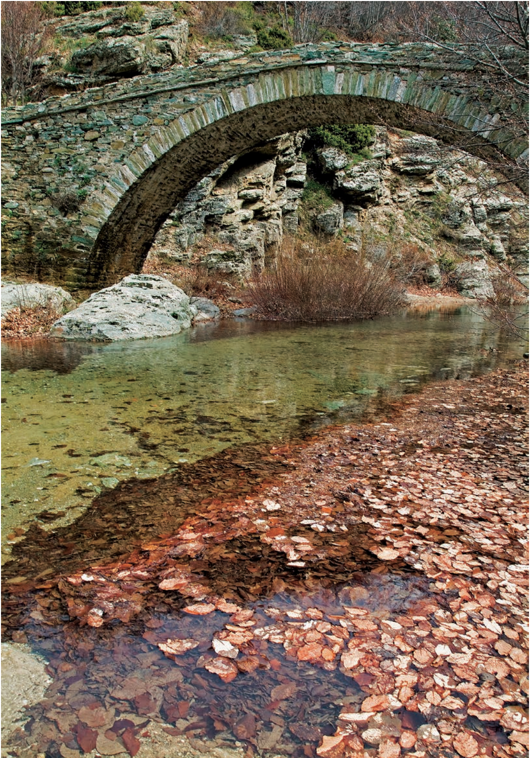
Βορειοδυτικά της Μακρινίτσας στο μονοπάτι προς Πουρί-Ζαγορά, το γεφύρι της Καρυάς πλάι στις οξιές, γεφυρώνει το ρέμα της Καλιακούδας από το 1931.
