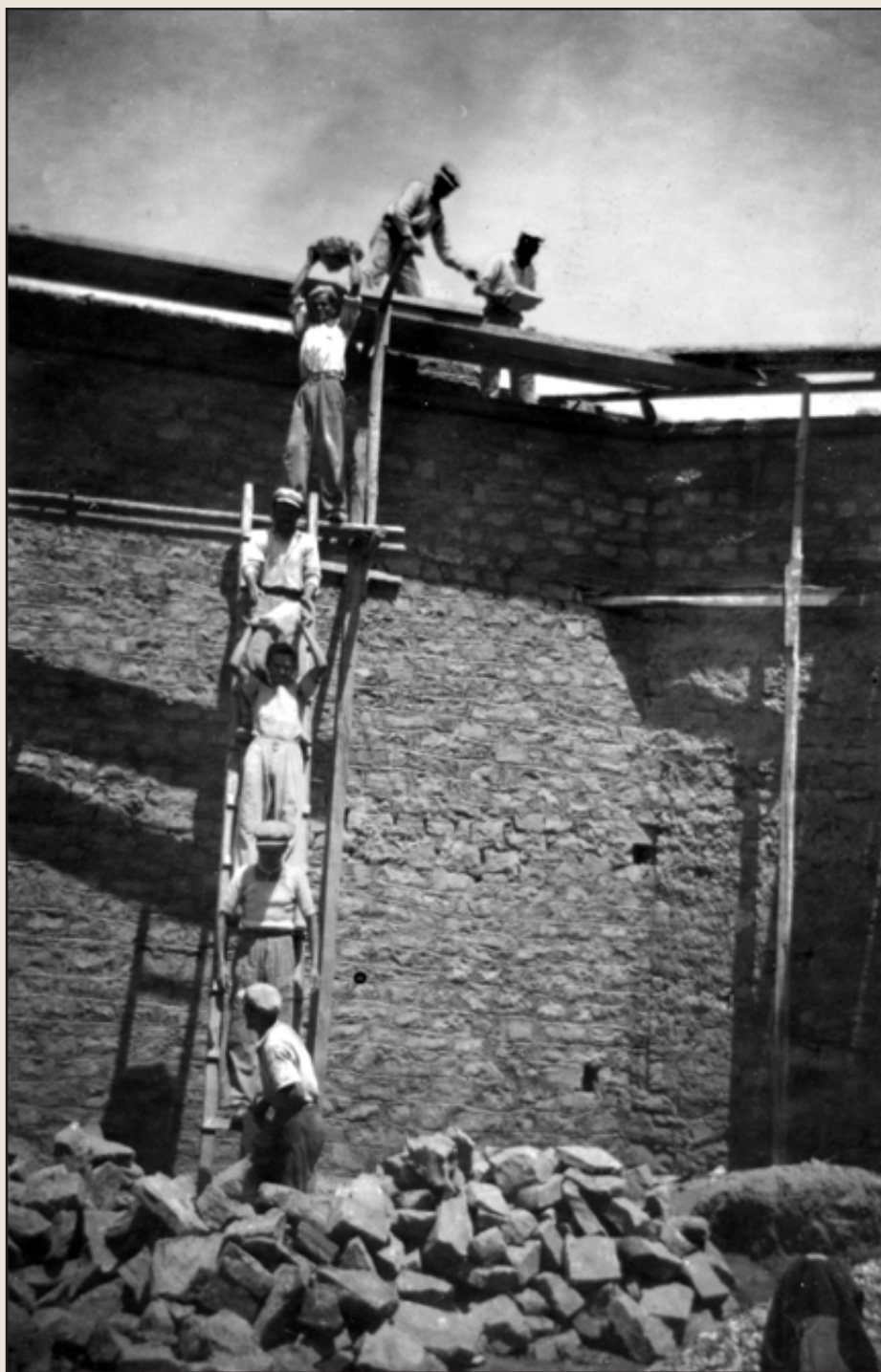
“Πάσα” : ανέβασμα πέτρας. Αγρίνιο 1949. Πυρσογιαννίτες μαστόροι χτίζουν τον κινηματογράφο των αδελφών Τσιτσιμελή.
