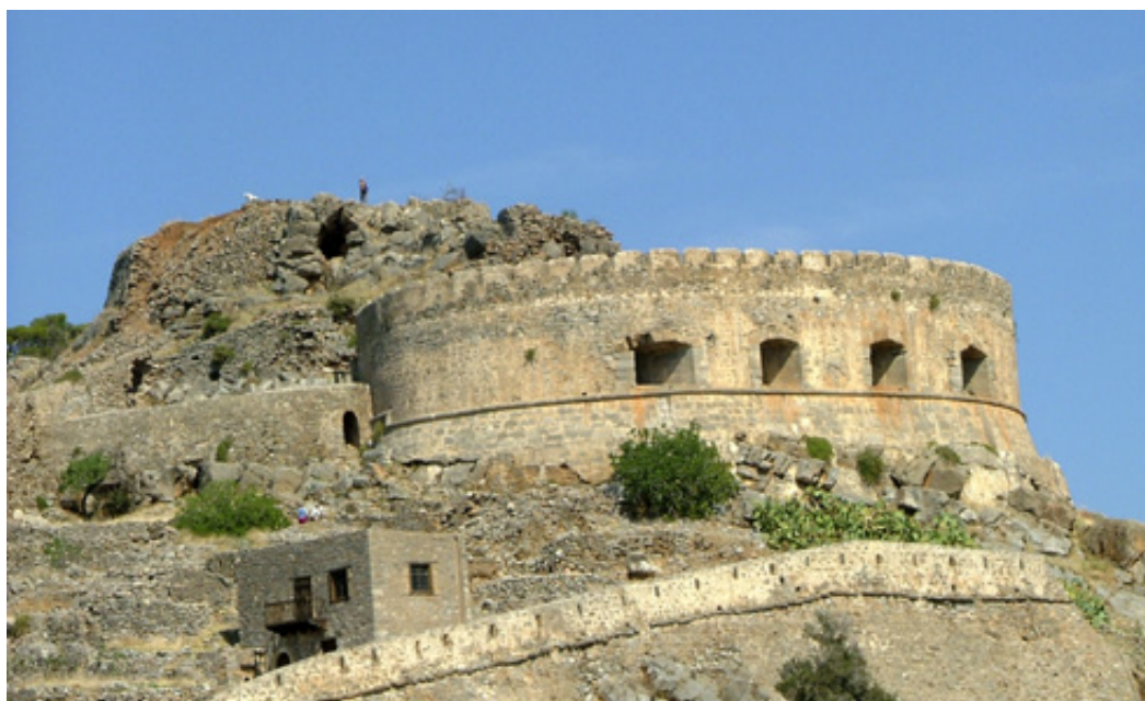
"Ντάπια" στην είσοδο του λιμανιού της Σπιναλόγκας. Φωτ.Κ. ΠΑΠΑΓΕΩΡΓΙΟΥ
