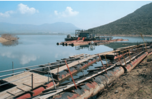
Παλιές εγκαταστάσεις της ΕΥΔΑΠ στη Υλίκη.
