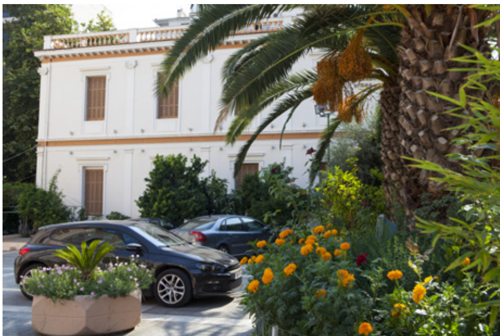
Το ιστορικό κτήριο του Ερνέστου Τσίπερ. Το «Κέντρο» κατά το Μακεδονικό αγώνα. Άποψη από την αυλή του μητροπολιτικού ναού Γρηγορίου Παλαμά.
