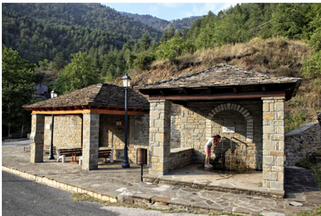
Με πέτρινη τοικοποιία και με πλάκα στην σκεπή, το κιάσκι και η κρήνη έχουν πολύ ομορφύνει την σύγχρονη εικόνα των Αρμάτων.
