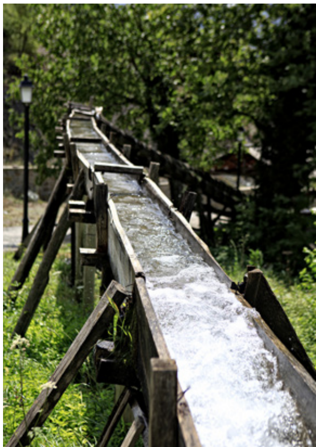
Από το αυλάκι διοχετεύετο το νερό στην καρούτα και με την ορμή που αποκτούσε έθετε σε λειτουργία το πρίονι
